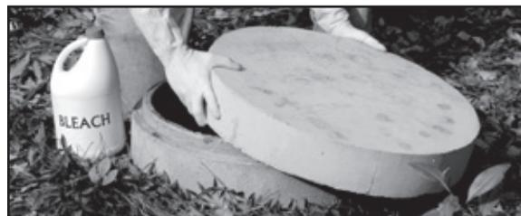
3. Tome el galón de lejía y el embudo (de ser necesario) y vierta cuidadosamente la lejía en la tubería del pozo.
