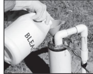
4. Después de agregar la lejía, utilice una manguera externa para verter agua en la tubería del pozo hasta que se perciba el olor a lejía en la salida de la manguera. Luego cierre la manguera externa.
